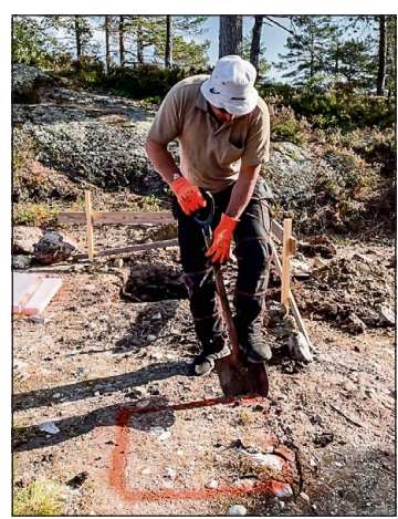
HÅNDMAKT: Det ble gravd med håndmakt. Her er det Yaser Hasan Hannouf som begynner på et nytt pilarhull.
